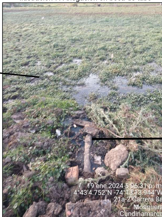
Ilustración 7. Anegación en boca de tubo
